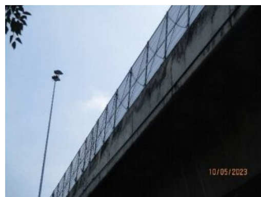
รูปที่ 2-26 กำแพงกันเสียงทั้งสองข้างของขอบทางด่วน บริเวณสวนสมเด็จพระศรีนครินทร์ เป็นระยะทางด้านละ 100 เมตร
