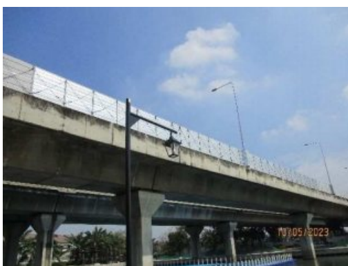
รูปที่ 2-26 กำแพงกันเสียงทั้งสองข้างของขอบทางด่วน บริเวณสวนสมเด็จพระศรีนครินทร์ เป็นระยะทางด้านละ 100 เมตร
