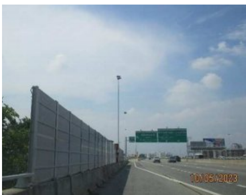
รูปที่ 2-13 กำแพงกันเสียงทั้งสองข้างของขอบทางด่วน บริเวณสวนสมเด็จพระศรีนครินทร์ เป็นระยะทางด้านละ 100 เมตร
