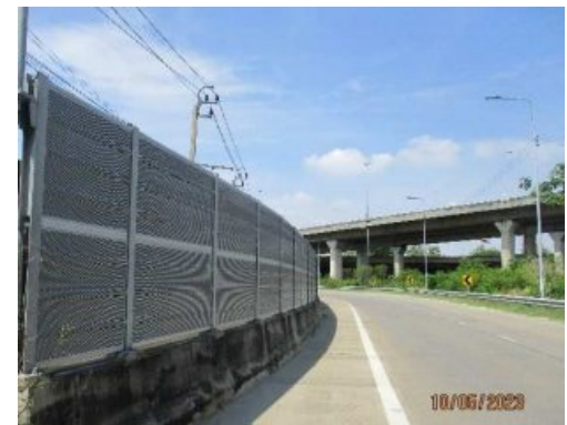
รูปที่ 2-9 กำแพงกันเสียงทางขึ้นจากถนนแจ้งวัฒนะไปทางทิศเหนือ บริเวณทิศตะวันตกของทางด่วน บริเวณหมู่บ้านผลพัฒนา (เดิมชื่อหมู่บ้านโสภณนิเวศ) เป็นระยะทาง 364 เมตร
