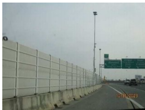
รูปที่ 2-13 กำแพงกันเสียงทั้งสองข้างของขอบทางด่วน บริเวณสวนสมเด็จพระศรีนครินทร์ เป็นระยะทางด้านละ 100 เมตร
